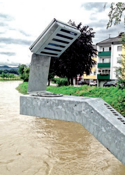
Radarsensoren auf Brücken messen den Pegel der Flüsse und senden ihn per Mobilfunk kontinuierlich in eine Leitzentrale.
