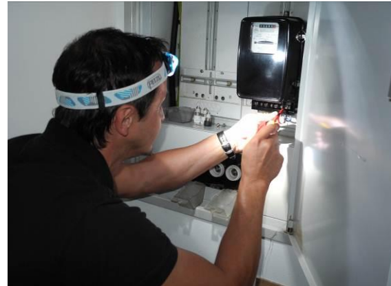
Abbildung 2: A1 Techniker beim Stromzählertausch
